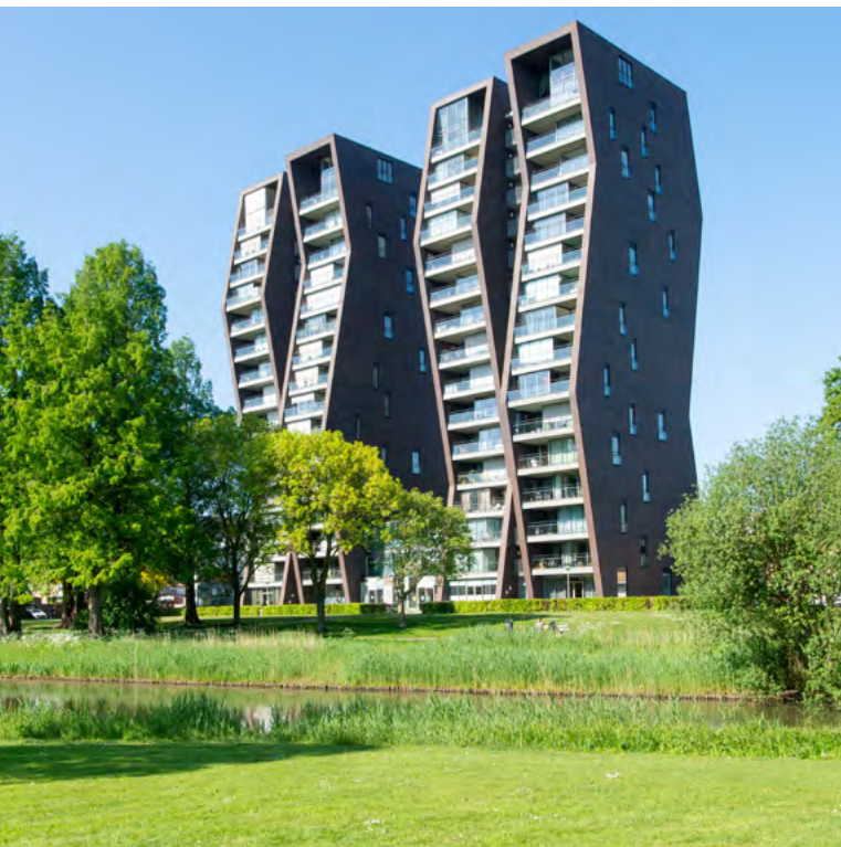
Eén van de duurzame complexen uit de portefeuille van Vesteda
